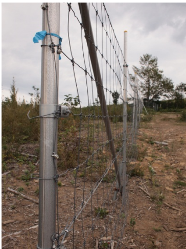
写真④ 補強された支柱と金具
