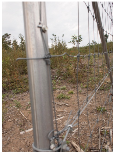
写真⑤ 新しく設置した太いワイヤー
